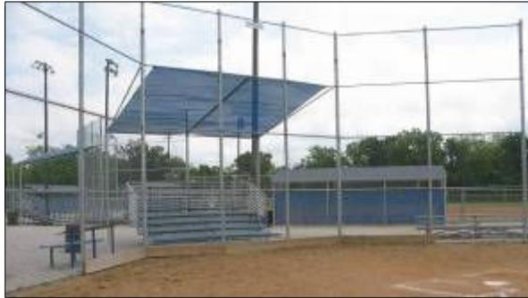
La cerca de protección se puede hacer de una cerca alambrada y/o redes y cables. La cerca de protección puede variar entre 10 a 20 pies y está determinada por los grupos de edad
