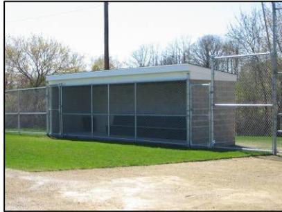
Las bancas se utilizan para proteger a los jugadores del tiempo inclemente y para proporcionar un área donde puedan descansar mientras el equipo oponente está en el campo. Las estructuras típicas de las bancas se deben diseñar para que quepa un equipo de 20 jugadores más los entrenadores. Esto requiere que una banca sea por lo menos de 60 pies de largo.
